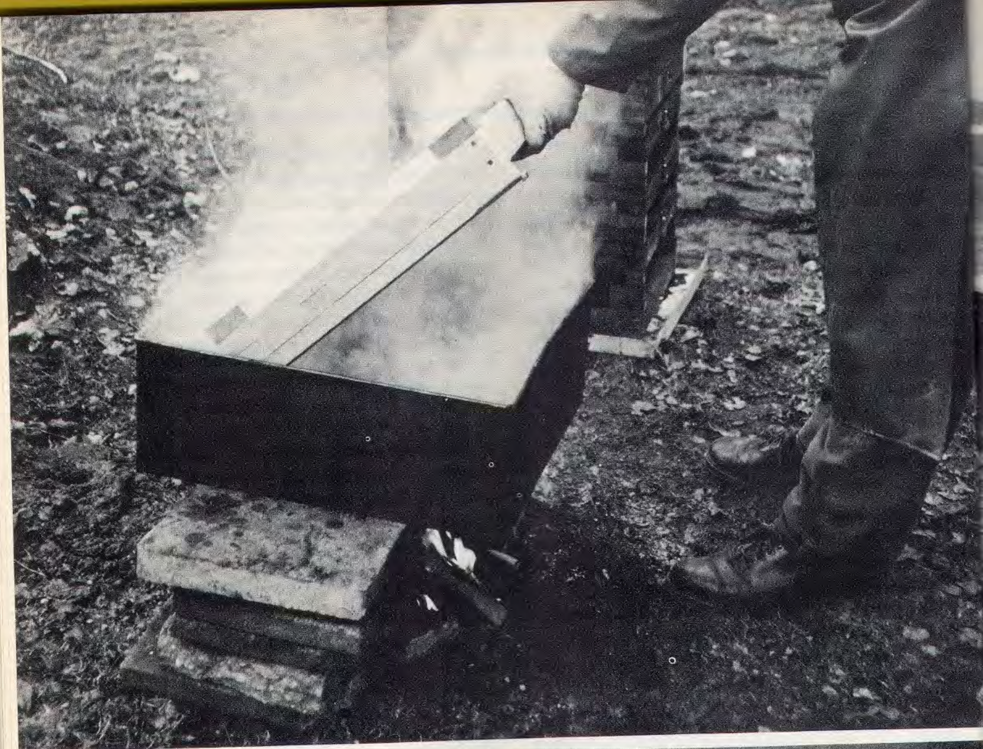
Abb. 1 (links oben): Der Gitterboden wird in heißes Karbolineum getaucht
