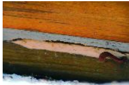
Hier wollte ein Untermieter einziehen, wie sich an den Nagespuren am durch einen Flugkeil eingengten Flugschlitz zeigt.
